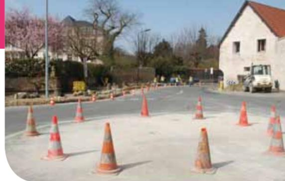
améliorer la sécurité des usagers. Les travaux en cours visent plusieurs objectifs. Le rond-point est décalé et rétréci pour faciliter son contournement par les véhicules et les bus. Le trottoir est élargi au niveau du virage. Des plots sont installés pour orienter et cadrer le passage des bus et limiter leur voie de circulation.
