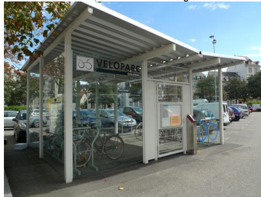
Local vélo sécurisé, ville de Strasbourg
