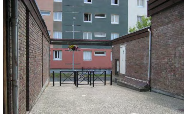
Le centre commercial de la place du 8 mai
