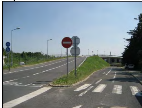
Le pont au-dessus de la Francilienne
